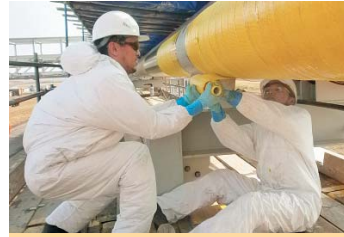
ООО «СК ИНТРА». Строительные работы на трубопроводе «Сахалин-1»
