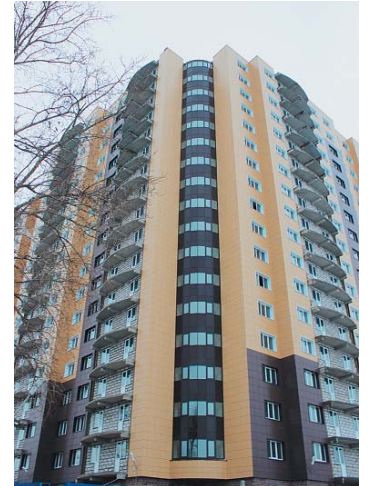
ООО «Лидер». Строительство ЖК в пос. Металлострой
