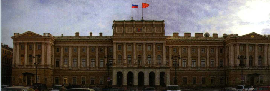
Мариинский дворец. (1839–44 гг., арх. А. И. Штакеншнейдер). Реставрация фасадов: ООО «Лалин Энттерпрайз»
